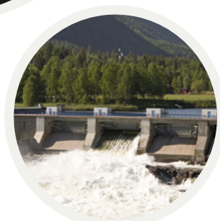
Энергетика Im Energiesektor Inom energisektorn
